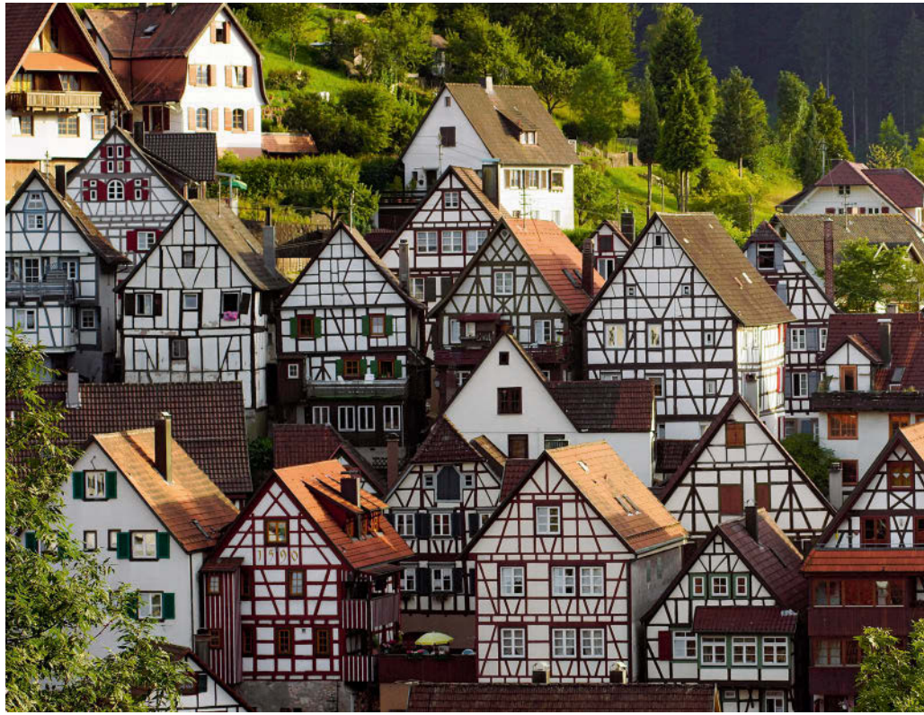
Auch Schiltachs Altstadt zeigt vielgestaltiges Fachwerk. Das mächtige Dach mittendrin mit einem Stufengiebel gehört zum reich bemalten Rathaus.
